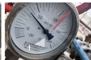
施工 出口内部
