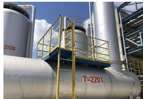
測定対象 未施工タンク
