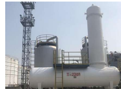
測定対象 施工タンク
